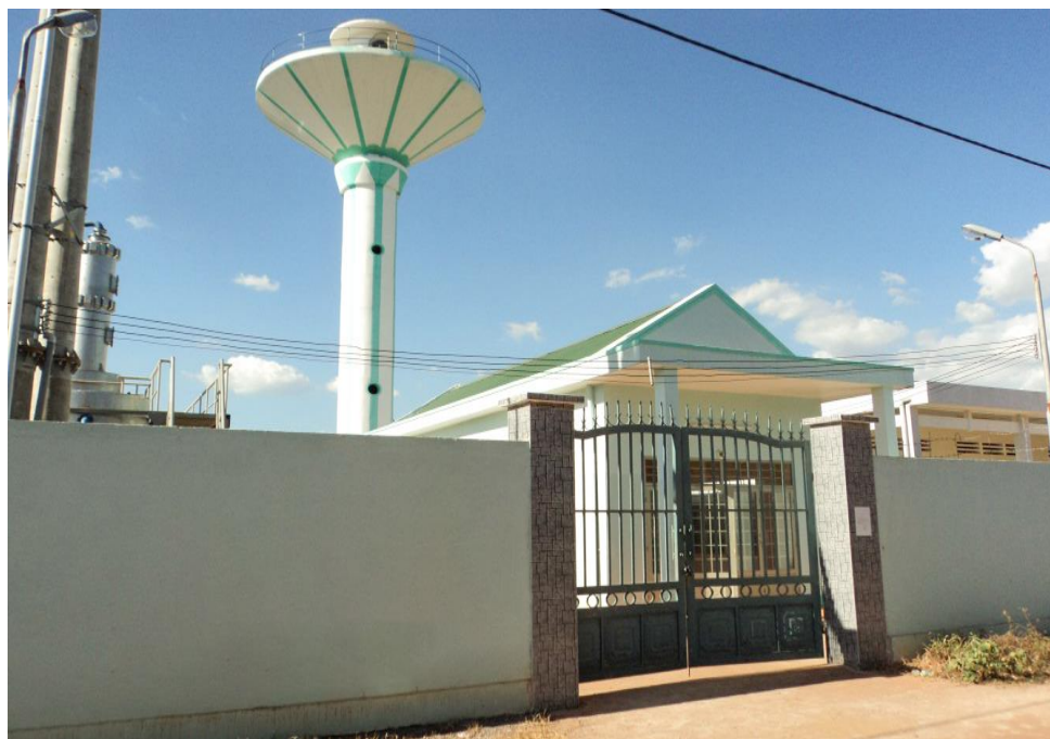
Hệ thống cấp nước sạch tập trung xã Phú Túc
